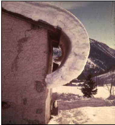
Figure 1.11 : Neige sur un toit. Sous l'effet de la différence de température entre la partie coté soleil et la partie coté toit, la neige s'est déformée plus rapidement là où la température est la plus élevée.
